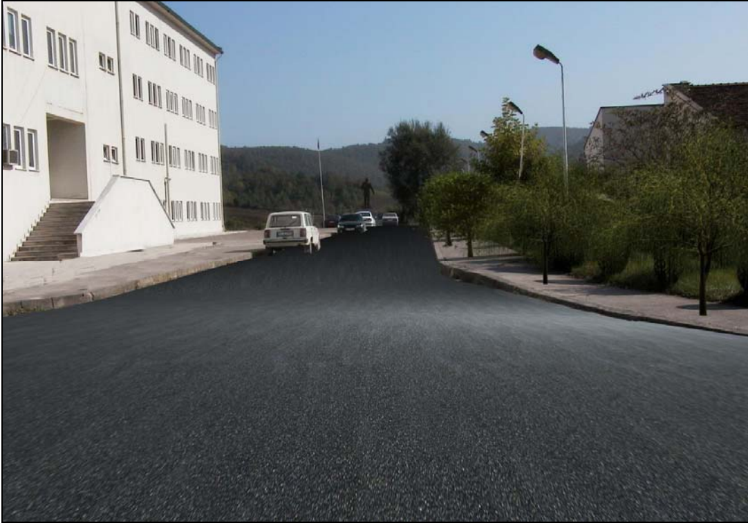
Şekil 11. Orman Fakültesi binasının şu anki görünümü ve düzenlenmiş hali.
