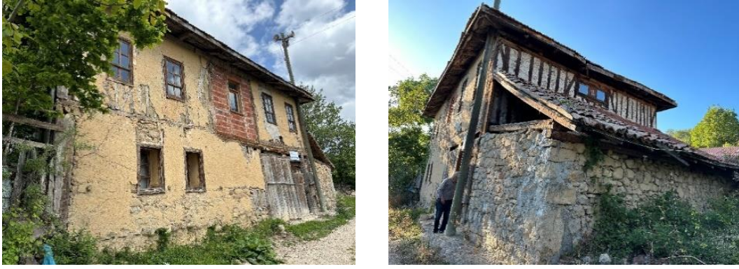
Şekil 14. Köy odasının güney ve doğu cepheleri
