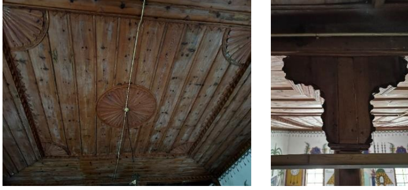
Şekil 38. Kışla köy odasının içinde bulunan caminin tavanı ve mahfil bölümündeki ahşap sütun başlığı
