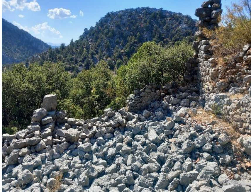
Şekil 5. GVK007 konutunun güney duvarı.
