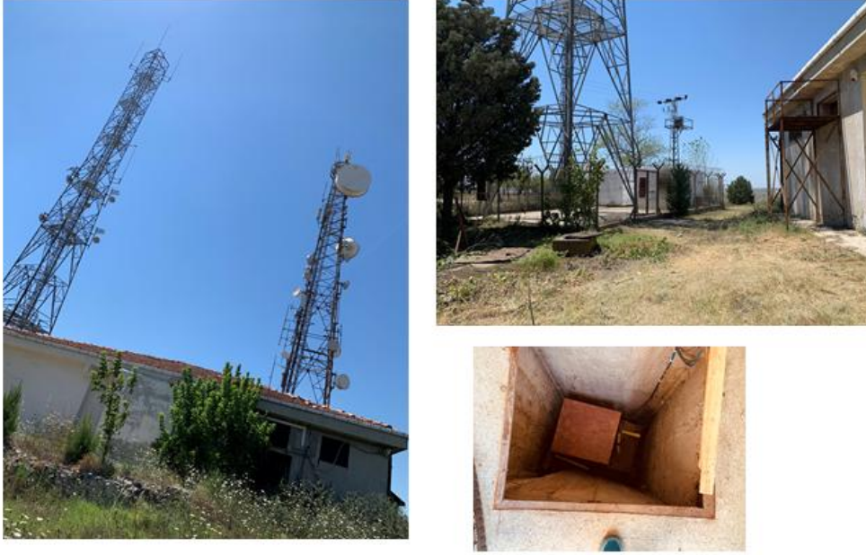
Şekil 11. CRLT istasyonundaki Jeneratör ve baz istasyonları (Generator and telecommunication base stations at the CRLT seismic station)
