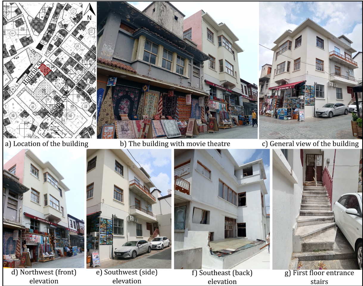
Figure 6. Location, general view and elevations of the building / Yapının konumu, genel görünümü ve cepheleri
