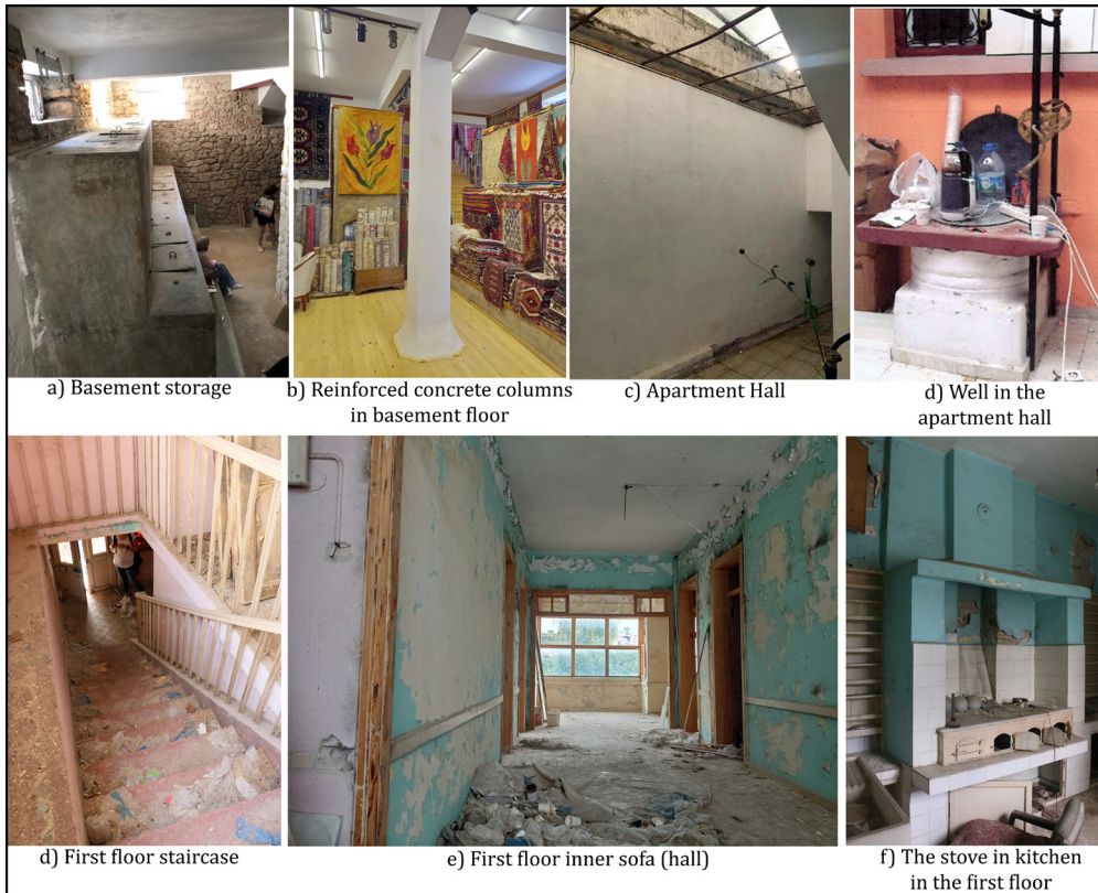
Figure 9. Interior photographs of the basement and the first floor d) Well in the apartment hall (Alper Erden Engiz Archive) / Bodrum katı ve birinci kata ait iç mekân fotoğrafları d) Apartman holündeki kuyu (Alper Erden Engiz Arşivi)
