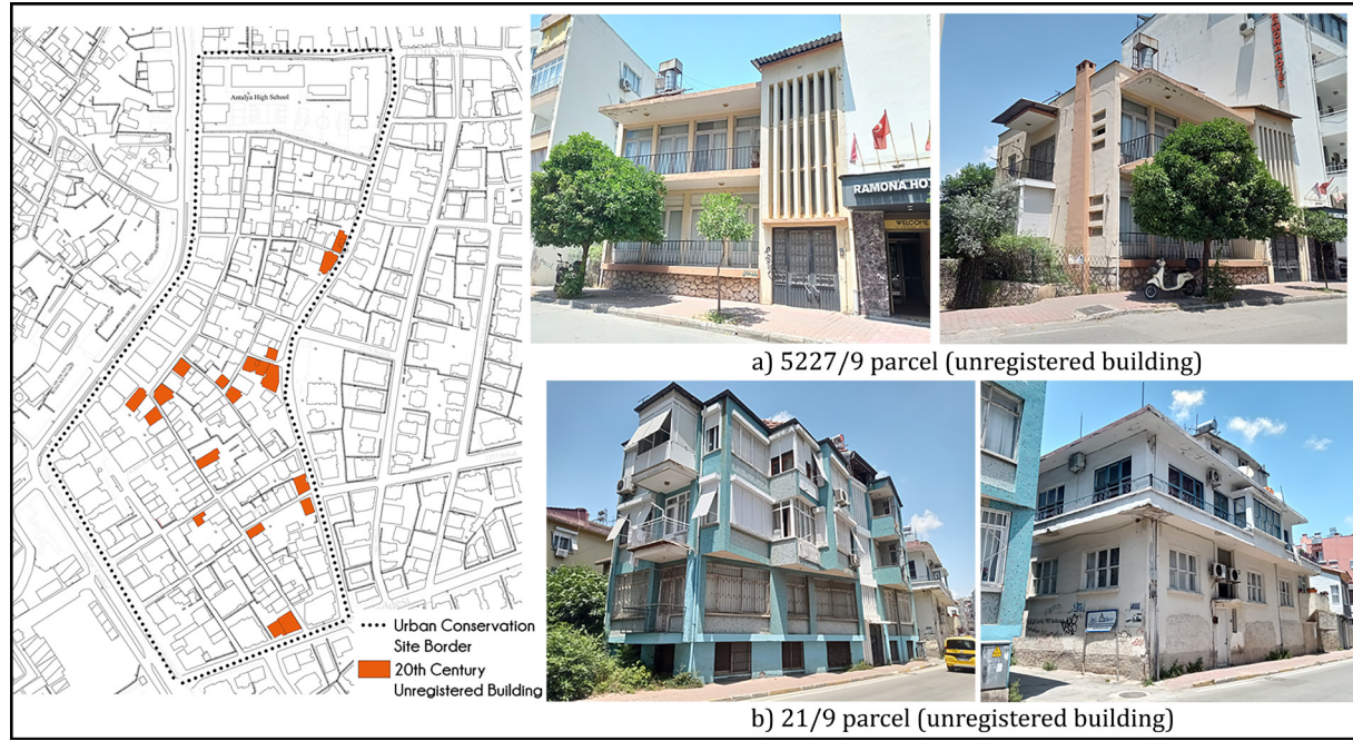
Figure 5. 20th century buildings in Haşim İşcan urban site (It was processed onto zoning map by authors using the findings and recommendations developed within the scope of the research, 2023) / Haşim İşcan kentsel sit alanındaki 20. yüzyıl yapıları (Araştırma kapsamında geliştirilen bulgu ve öneriler kullanılarak yazarlar tarafından imar planı üzerine işlenmiştir, 2023)
