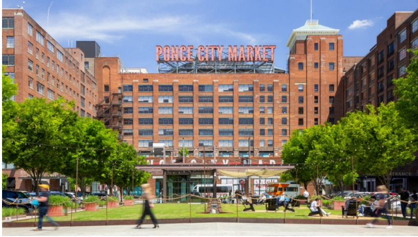
Şekil 2. Ponce City Market'in Genel Görünümü
