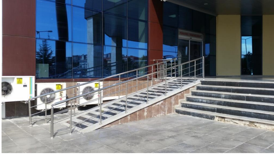
Foto 12. Yemekhane binası girişi engelli rampası [19]
