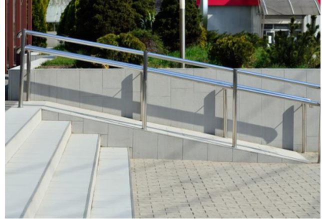
Foto 2. Bina girişi engelli rampası [10]
