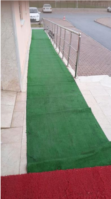
Foto 13. Lojmanlar binası girişi engelli rampası [20]
