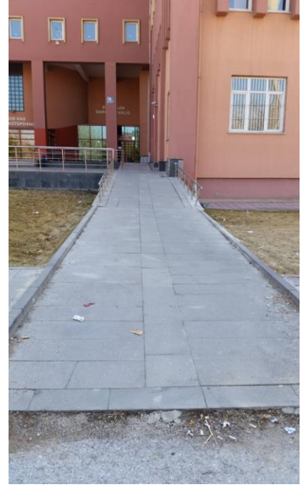
Foto 9. Kütüphane binası giriş engelli rampa uygulaması [19]
