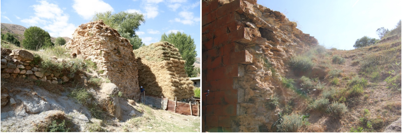
Fot. 11, 12: Yapının güneydoğu ve kuzeybatı yönlerden görünüşü.
