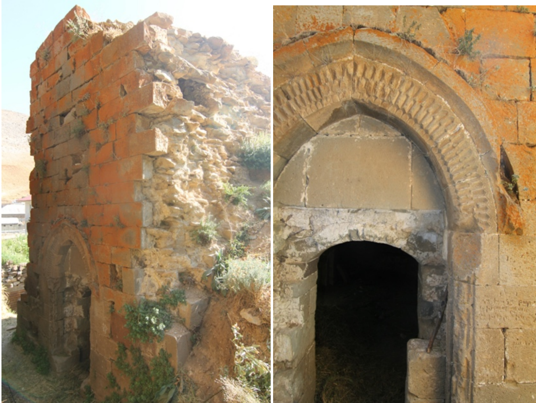
Fot. 5, 6: Kamah Kilisesi batı cephesi ve giriş kapısından görünüş.
