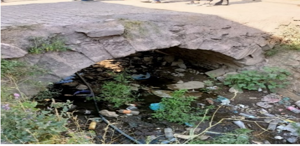
Resim 4: Arıdağ Köyü Köprü 2 genel görünüm
