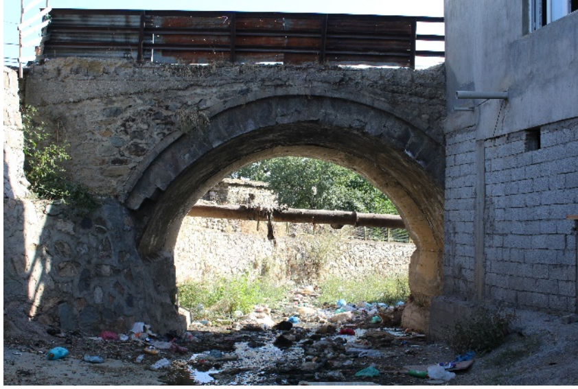
Resim 3: Arıdağ Köyü Köprü 1 genel görünüm
