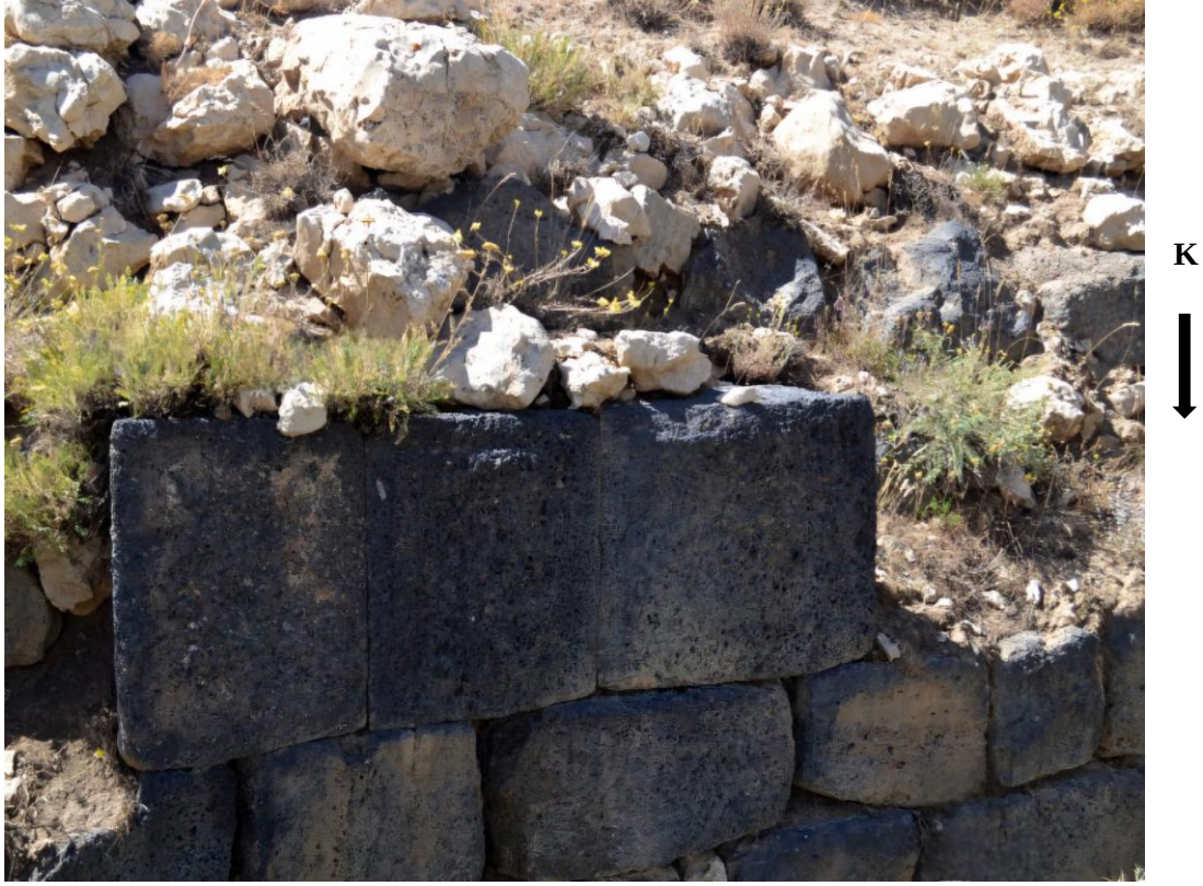
Şekil 5. Bazalt Kuzey Sur Duvarları
