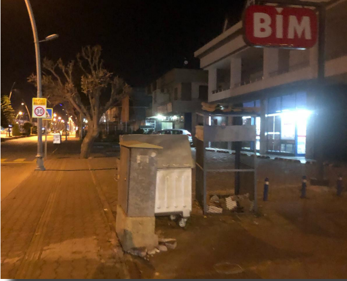
Resim 9: Dr. Derviş Eroğlu Dörtüyl Bulvarı'nda aydınlatma elemanlarının yeterliliği.
