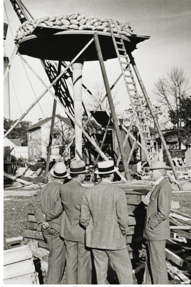
Şekil 2. Frank Lloyd Wright, Johnson Wax Binası'nda Kullanılan Mantar Kolonların Yük Taşıma Testleri Yapılırken 1937 (URL-3)
