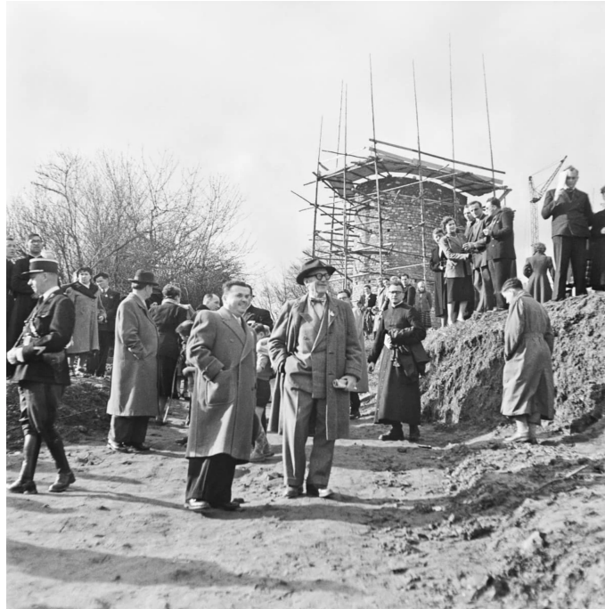
Şekil 6. Le Corbusier Notre Dame du Haut Şapeli Şantiyesinde, 1954 (URL-13)
