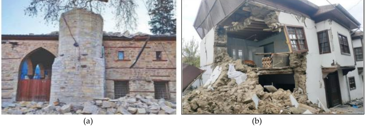
Şekil 1: 6 Şubat 2023 depremlerinde hasara uğrayan (a) bir minare [8] ve (b) bir geleneksel konut [11].
