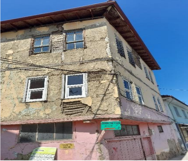
Şekil 4: Kullanılmayan tescilli bir binada (Ç1) cephede sıva dökümleri.
