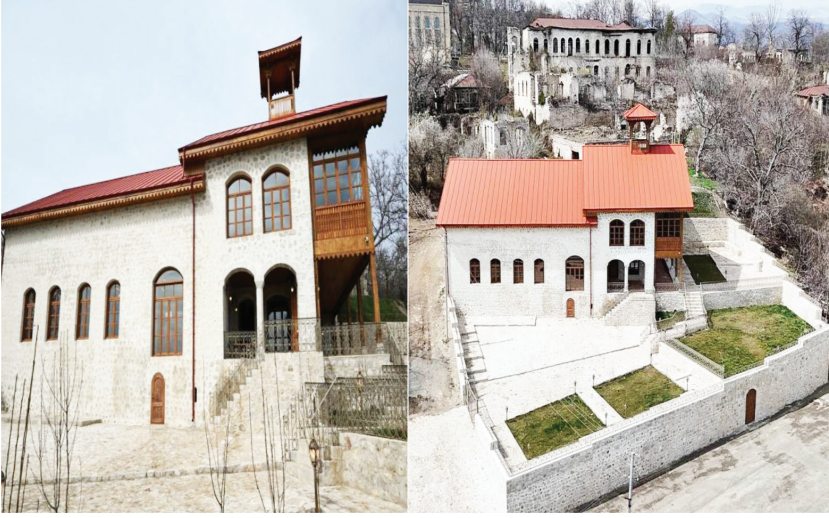
Fotoğraf 2. Çöl Kale Camii, Restorasyon Çalışmalarından Sonra, 2025
