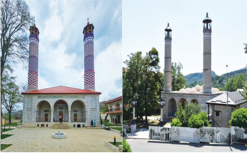
Fotoğraf 1. Yukarı Gövher Ağa Camii, Restorasyon Çalışmalarından Sonra, 2023
