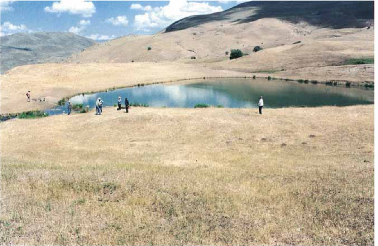
Resim 16: Yoğunhasan göleti ve yıkılan kuzey duvarı
