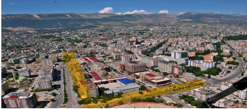
Görsel 6: Depremden Önce Hayrullah Mahallesi
