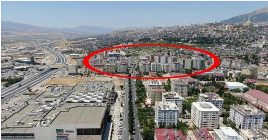
Görsel 8: Depremden önce Şazibey Mahallesi
