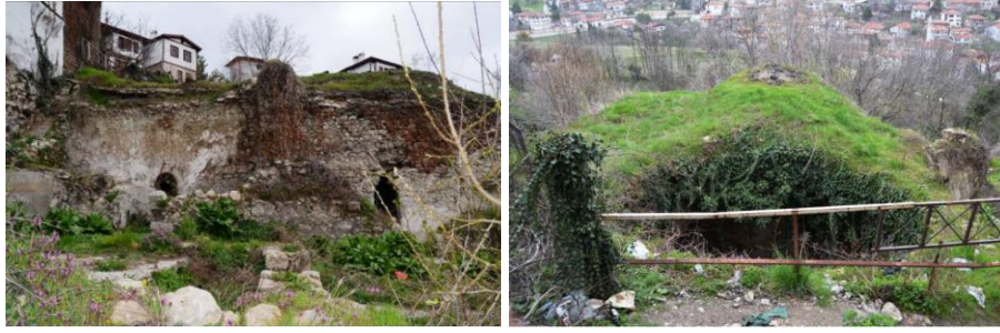
Şekil 6: Kıranköy, Küçük Rum Hamamı, Güney Cephe ve Örtü Sistemi
