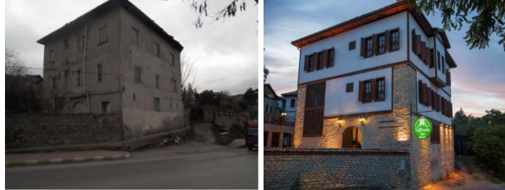
Şekil 17: Safranbolu, İnönü Mahallesi, Saffronia 1900 Konak Otel, restorasyon öncesi ve sonrası
