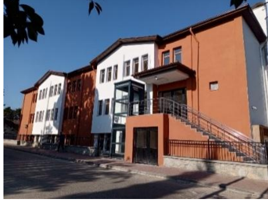
Şekil 15. Safranbolu, Barış Mahallesi, Misakı Milli İlköğretim Okulu
