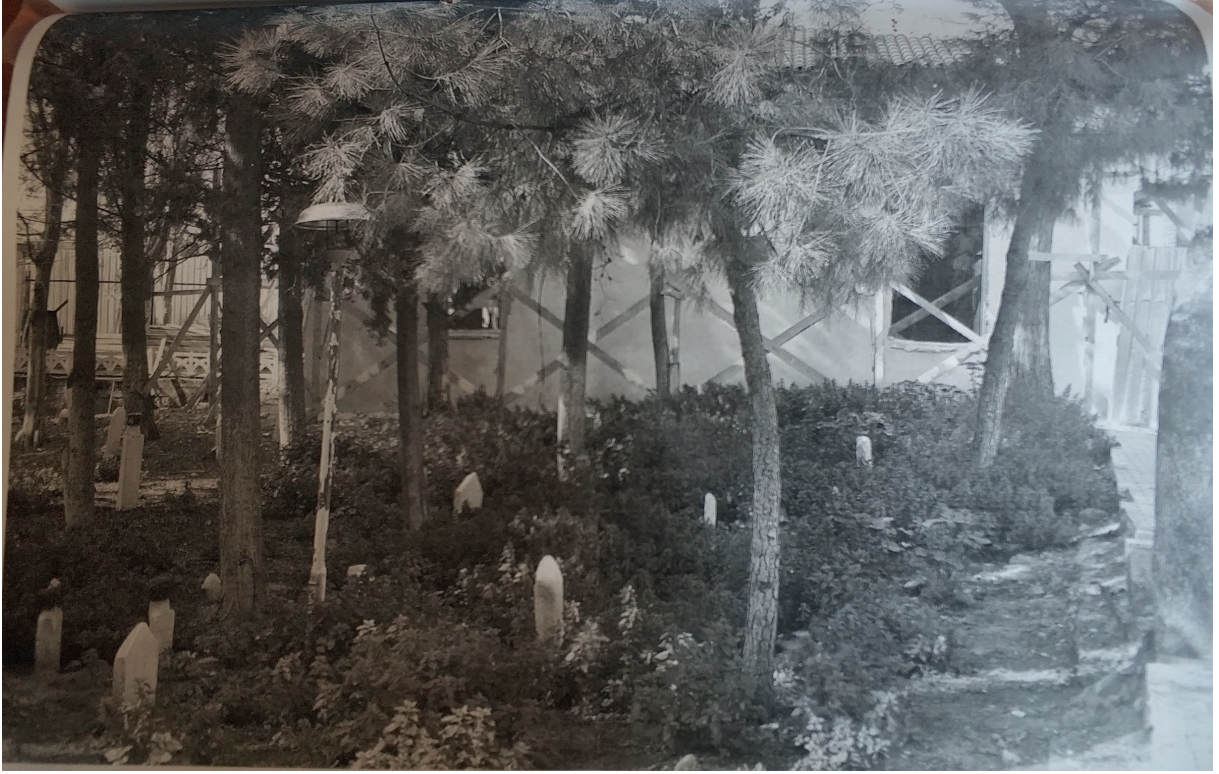
Şekil 4. Caminin güney cephesinden görünüm, 1980 civarı / View from the south side of the mosque, around 1980 (VGMA)
