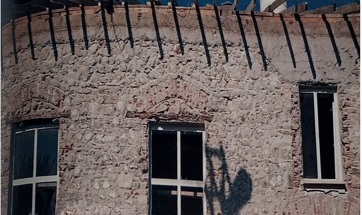
Şekil 5. Caminin doğu cephesinden detay, 2014 yılı / Detail from the east facade, 2014 (VGMA)
