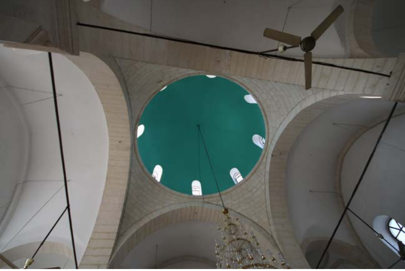
Foto 19. Caminin Merkezi Kubbesi
