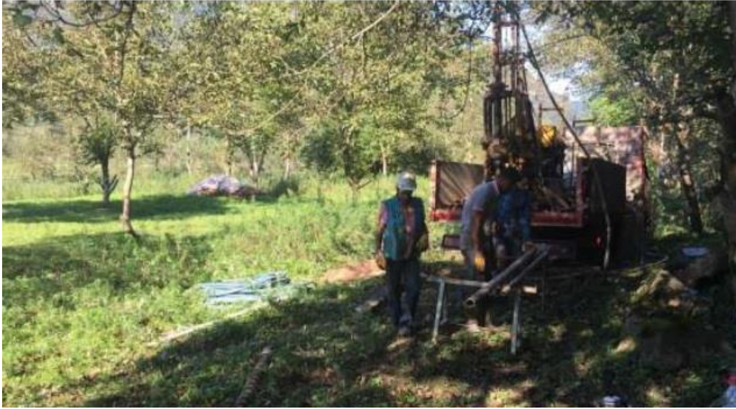
Şekil 3. Heyelanın topuk bölgesi yakınlarında gerçekleştirilen sondaj çalışması
