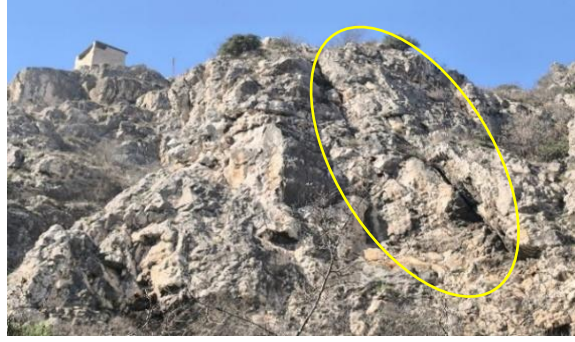
Şekil 12: Şev-1'de blok devrilmesi yenilmesine maruz kalabilecek kısımlar
