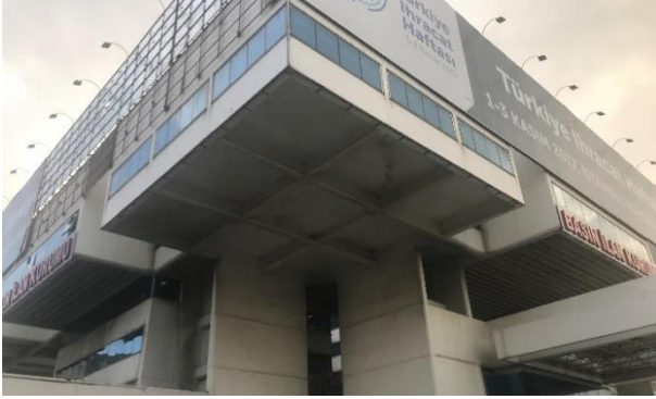
Şekil 13. Ofis Binası'nın 11m uzunluğundaki konsolu
