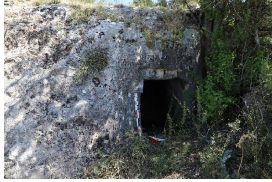
Fig. 3a: KM2 dıştan görünüm.
