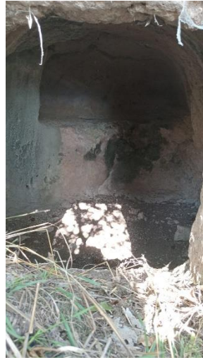
Fig. 8b: KM7 içten görünüm.
