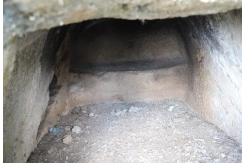
Fig. 3b: KM2 içten görünüm.
