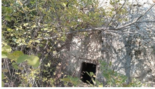
Fig. 8a: KM7 dıştan görünüm.
