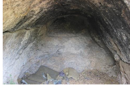
Fig. 12b: KM17 içten görünüm.
