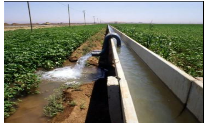
Şekil 2.3 Kanaletli Sulama Şebekesi – Şanlıurfa Harran
