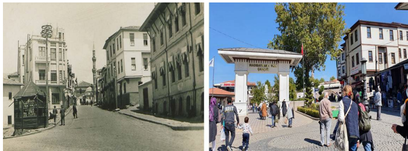
Resim 4. 1930’lu yıllarda Hacı Bayram Veli Camii’sine uzanan Hacıbayram Sokak (sol) ve günümüzdeki durumu (sağ).
