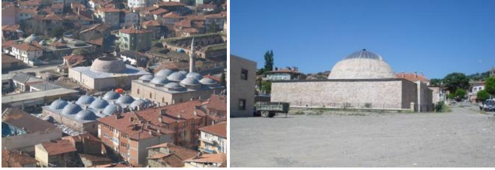
Görsel 35. 2007 Yılında Yapının Kubbesinin Kapatılmadan Önceki Durumu ve 2012 Yılında Yapının Kapatılmış Kubbesi (Akın Saka ve Ercan Kalınbayrak, 2023: 322)
