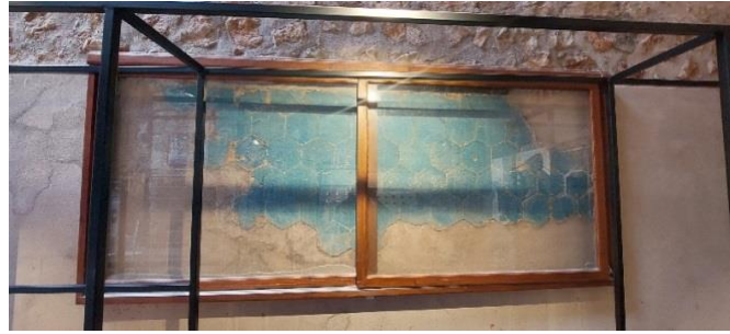
Görsel 40. Yapının güney eyvanındaki koruma altındaki Çiniler (Yazar Arşivi, 2024)
