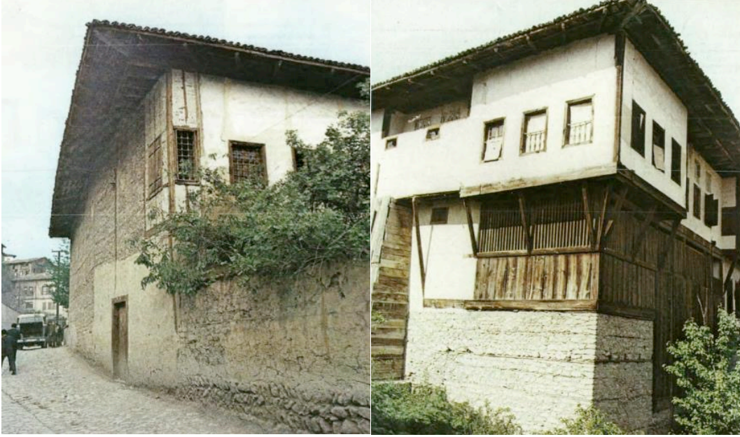
Şekil 5. Safranbolu'da bulunan Türk evinin sokağa ve hayat bölümüne bakan cepheleri (Küçükerman, 1985; Atıcı, 2023).
