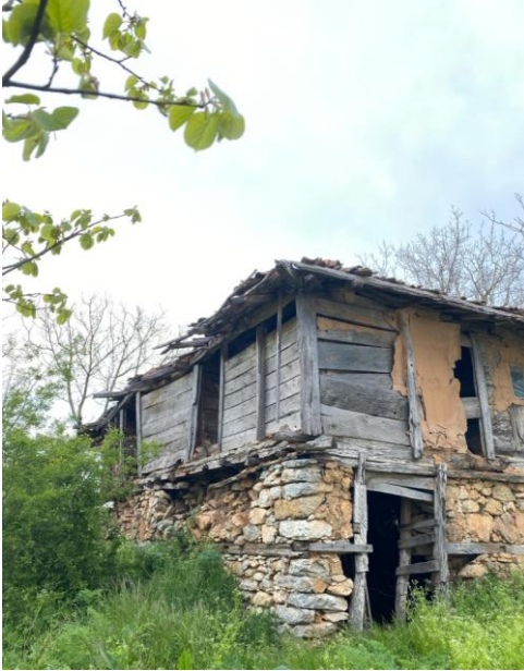
Ek 9: Eski bir Bulgar evinde bulunan ev ısıtma ocaklığı, Çağlayık Köyü
