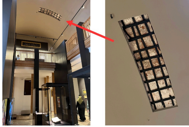
Görsel 7. Topkapı Sarayı Hazine Hademeleri Koğuşu'nun demir iskeletli kagir tonozundan görünüm Kaynak: Emel Akay; Nisan 2025
