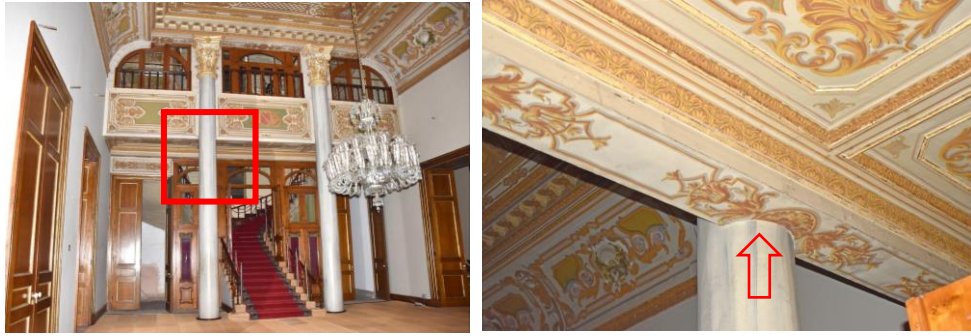
Şekil 15. Zemin Kata Sonradan Eklenen Ahşap Sütun ve Kesintiye Uğrayan Bezemeler
