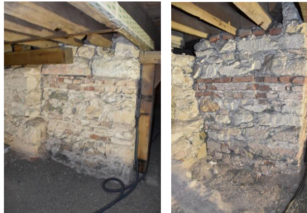
Şekil 17. Bodrum Kata Sonradan Eklenen Kâgir Ayaklar (Foto: Han, B.)
