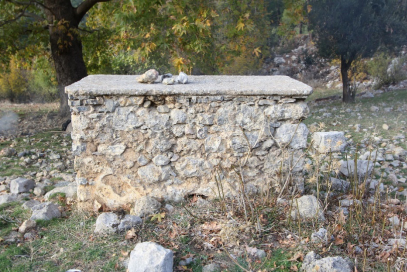
Levha 11: Hanın Çeşmesi Arka Cephe
