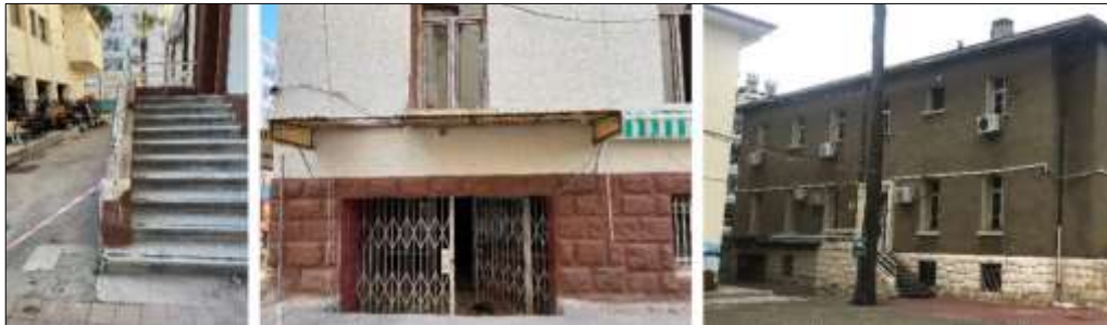
Şekil 29. Zemin kotu altında kalan basamaklar (solda) ve cephede ilaveler (orta, sağda) (Yazarlar)
