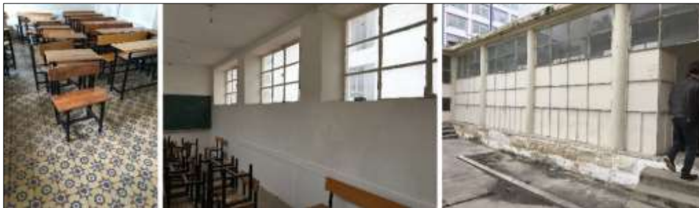
Şekil 26. Kaldırılan duvarın döşemede izi (solda); pergolanın kapatılması (ortada, sağda) (Yazarlar)
