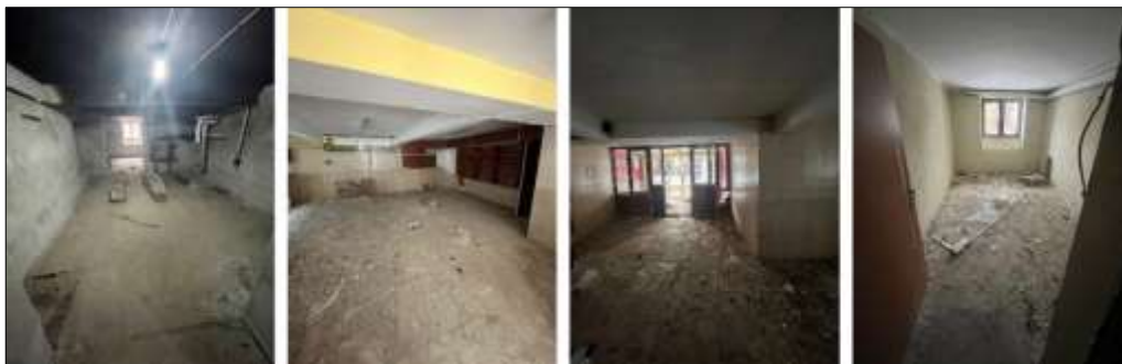
Şekil 10. Bodrum kat doğu kanadı mekânları, 2024 (Yazarlar)
