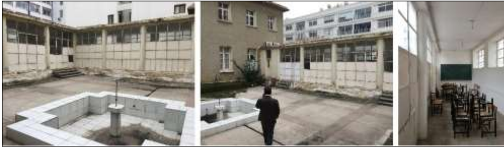
Şekil 7. Avluyu çevreleyen pergolaların kapatılması, 2022 (Yazarlar)
