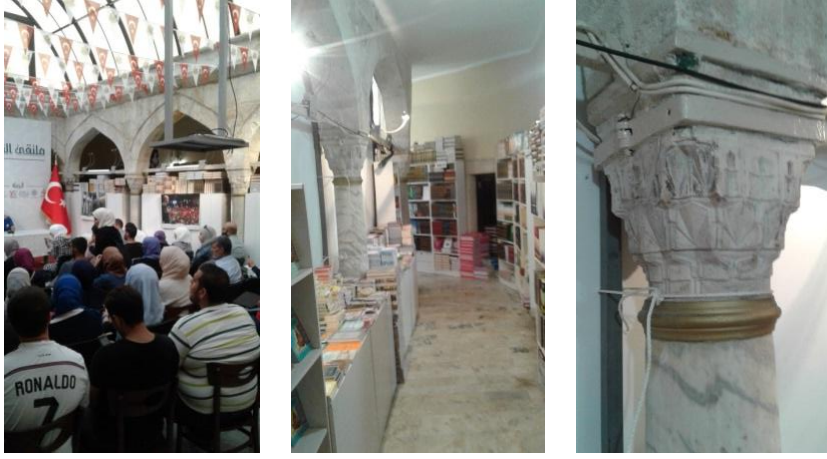
Şekil 38-39-40: Mehmet Ağa medresesi avlu, revak, tesisat ekleri (2017)
