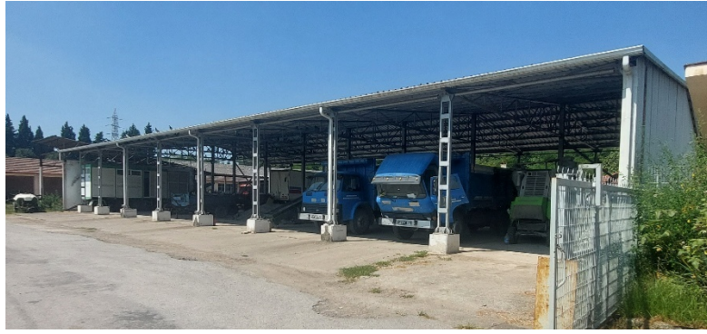
Şekil 16. 1972 yılında inşa edildiğinde betonarme olan ve bugün çelik yapım sistemi ile yeniden yapılan Garaj (Yazarlar Arşivi, 2025).
