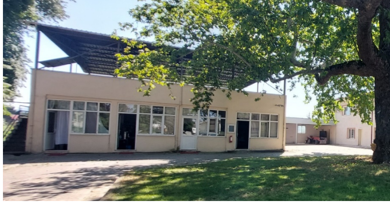
Şekil 19. 1943 yılında inşa edilen atölye binasının yerinde 2000 yılında yapılan işçi sosyal binası bulunmaktadır (Yazarlar Arşivi, 2025).
