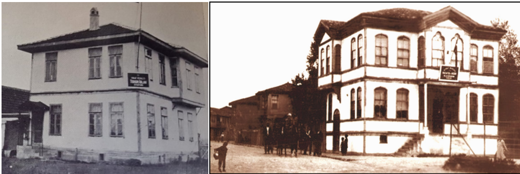
Şekil 1. Adapazarı Çark Mevkinde ve Merkezde Kullanılan İlk Patates- Mısır Araştırma Enstitüsü Binaları (Tarım Bakanlığı, 1962 ve Resul Narin Arşivi).
