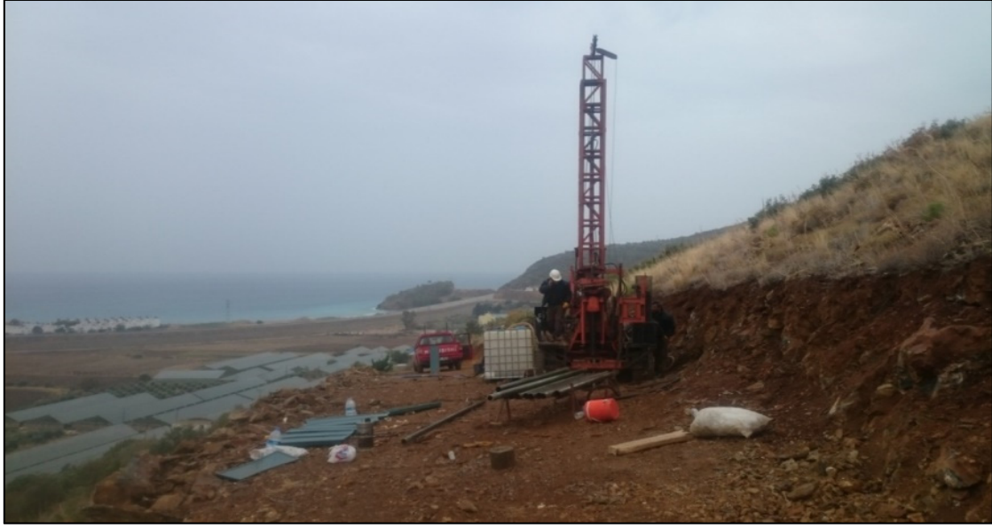
Şekil 5. Tünel giriş portalında açılan araştırma sondajından bir görünüm
