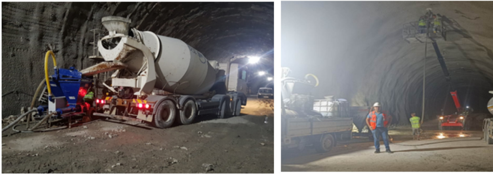
Şekil 12. Hafif köpük betonun hazırlanması ve tavanda uygulanması
