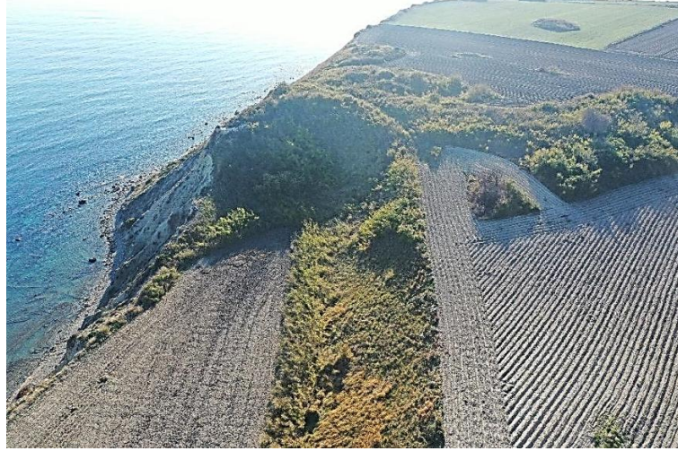
Şekil 14: Stadion, kuzey tribün, güneybatı sphendone ve çökmüş güney tribün alanı (Fotoğraf: F. Erhan)
