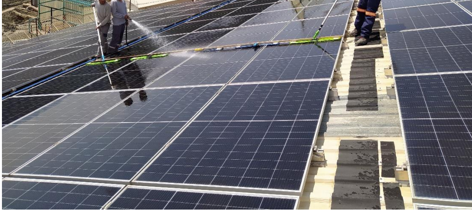
Şekil 7. Panel Temizleme Figure 7. Panel Cleaning
