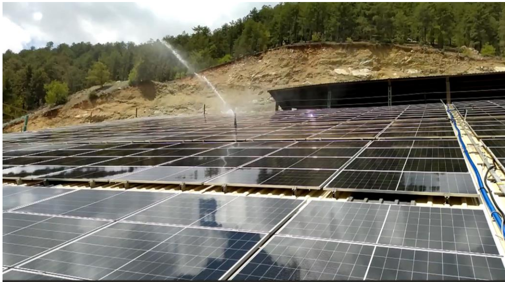
Şekil 17. Panel Temizliği Figure 17. Panel Cleaning
