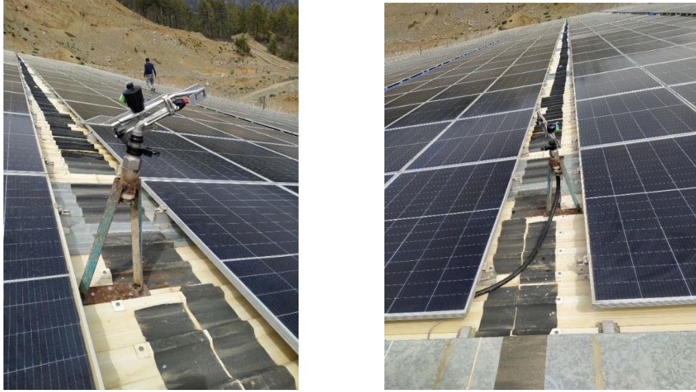
Şekil 6. Fıskiye Montajı Figure 6. Squirt Assembly
