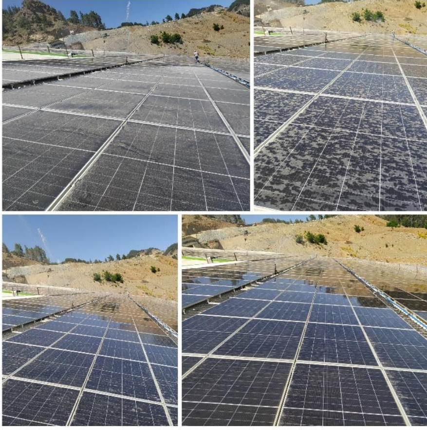
Şekil 16. Panel Temizliği Figure 16. Panel Cleaning
