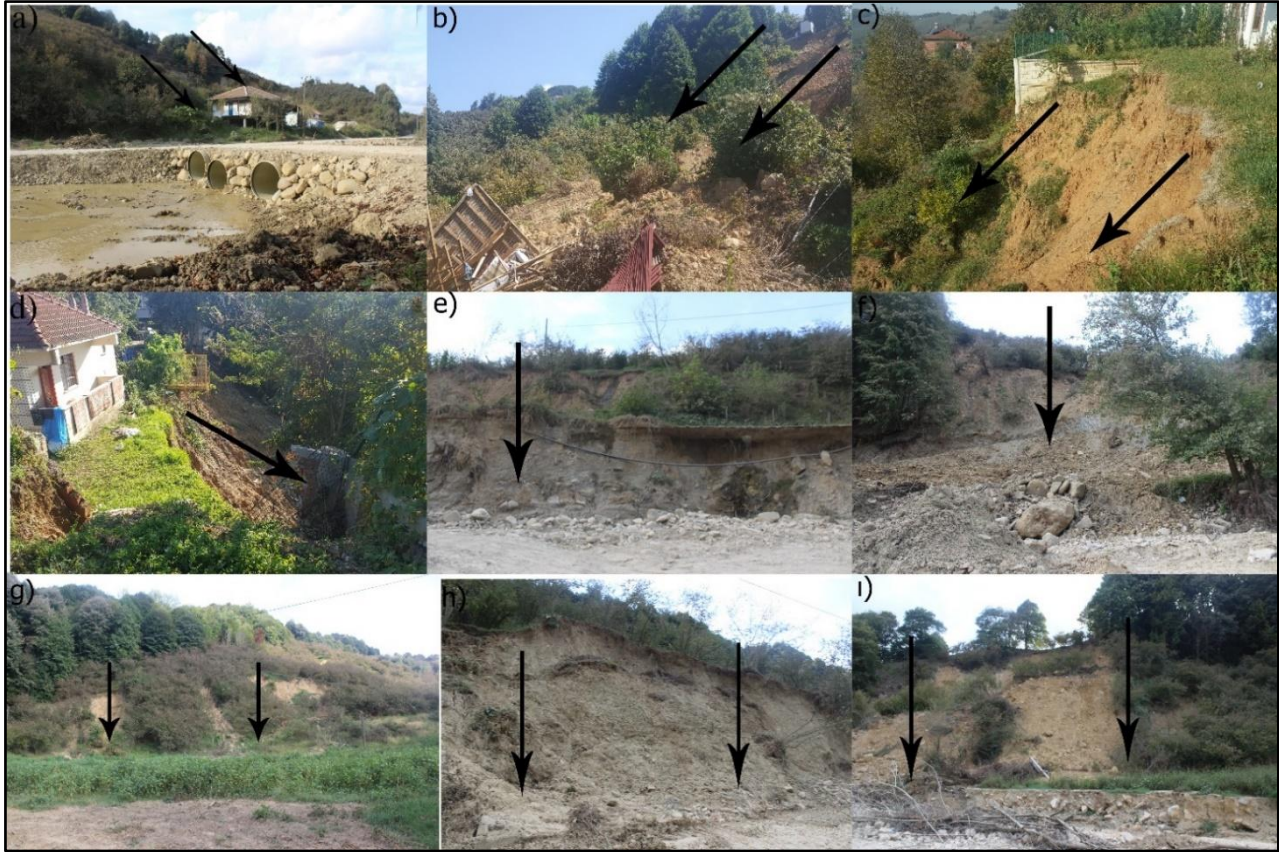
Şekil 2. Çalışma alanında yerleşmeleri (a, b, c, d), yolları etkileyen (e, f, h, i) ve orman alanlarını (g) etkileyen heyelanlar (b, c, d fotoğrafları Düzce İl Afet ve Acil Durum Müdürlüğünden alınmıştır).
