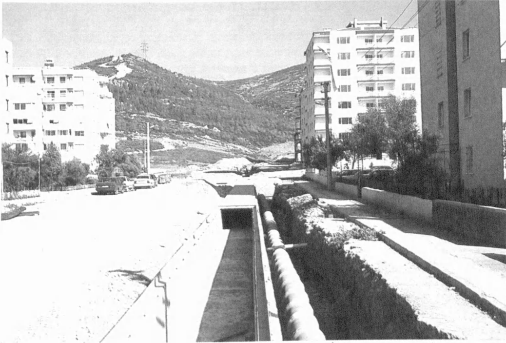
Foto: 20- Kasım 1999 . Çilekdağı tepenin eteklerinde yapılan Dallık dereleri kuşaklama kanalı. Bu kanal ile Dallık derelerinden gelen sular ile Çilekdağı tepe çevresinden kaynaklanın yüzey suları toplanarak Örnekköy deresine boşaltılacak, böylece Çukur mahallenin sel baskını tehlikesi önlenmiş olacaktır. Yapılan kanal çok dardır (1-1.5 m) ve suları toplayabilecek kapasitede değildir.
