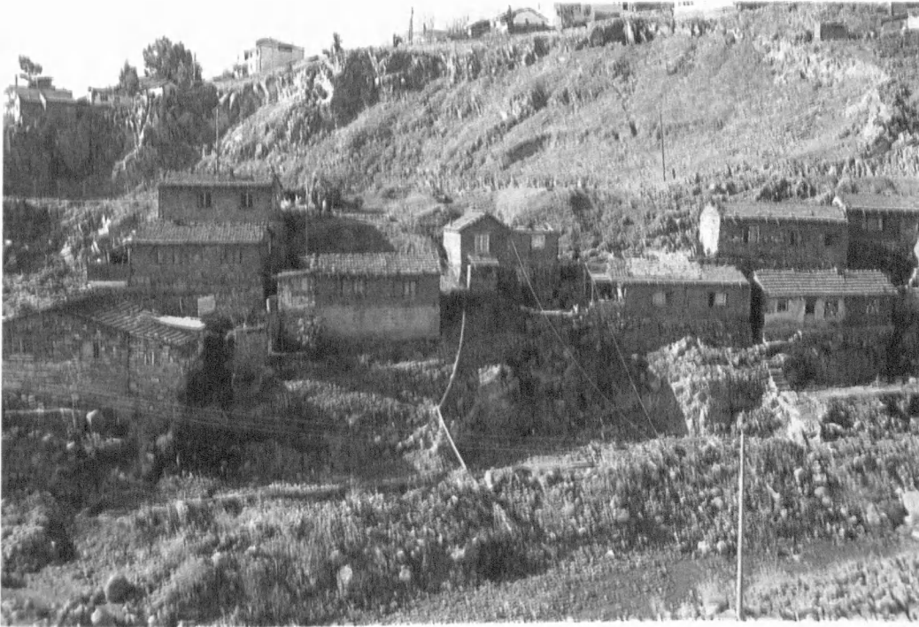
Foto: 4- Kasım 1999. Kavaklıdere vadisi. Selin birçok can aldığı yatak içinde sel sırasında yıkılan yapılar temizlenmiş olmakla birlikte, yatağın kenarındaki yapılar henüz ortadan kaldırılmamıştır.
