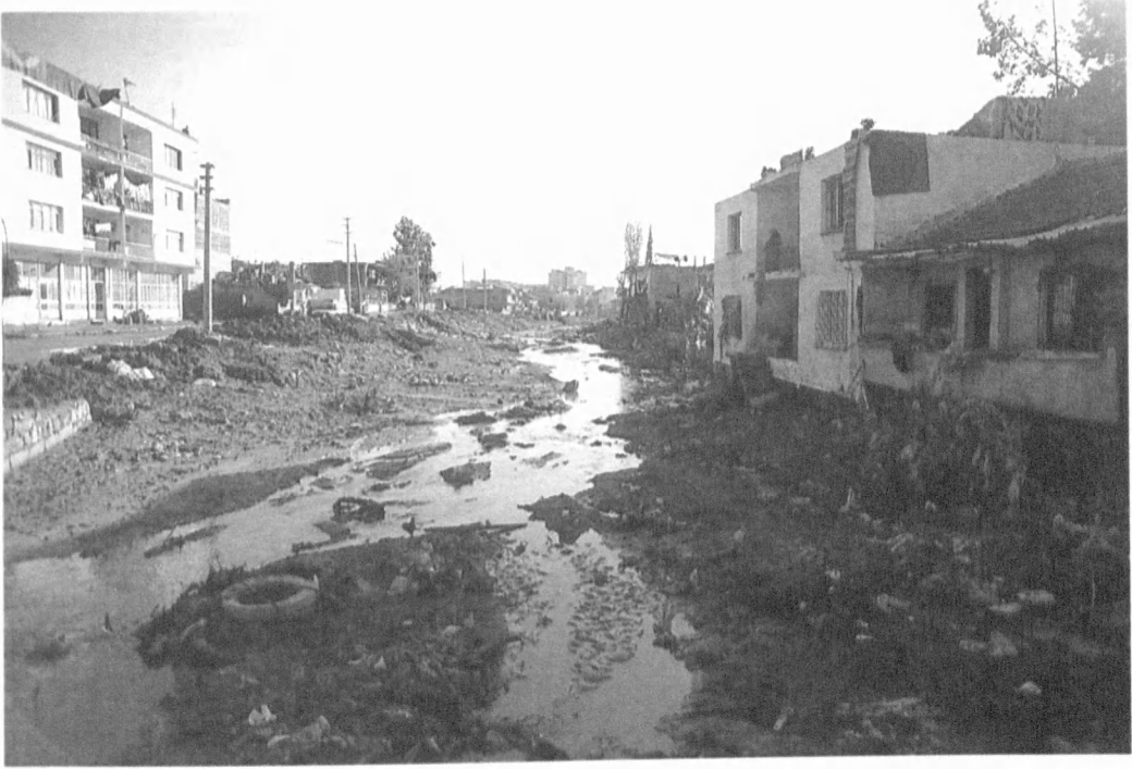
Foto: 11- Kasım 1995. Örnekköy deresi. Suyun akışını sağlamak için dar büzlerle geçilerek yapılan yolun üzerinden, taşan sular dere kenarında yer alan sokaklardan itibaren 3-3.5 m kadar yükselmiştir.
