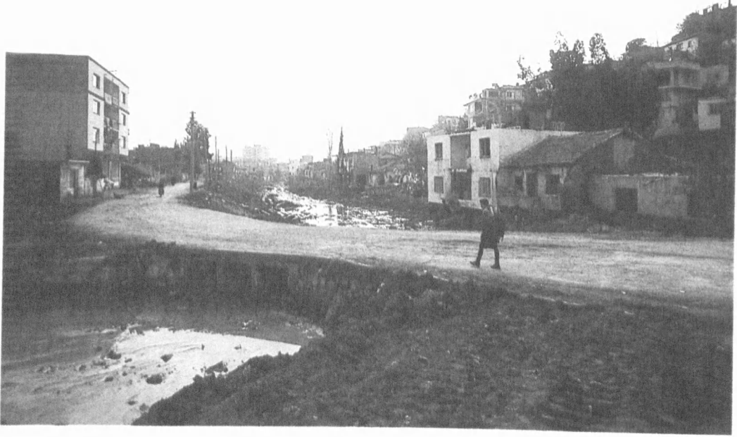
Foto: 9- Kasım 1995. Örnekköy deresi. İki derenin birleşme noktasında yer alan ve suyun akışını sağlamak için dar büzlerle geçilerek yapılan yol. Bu hatalı yapım da, selin bu noktadan itibaren yayılmasını kolaylaştırmıştır.
