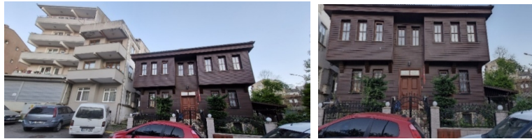
Şekil 50. Çok katlı apartman blokları yanında kapsamlı restorasyon geçirerek yenilenen geleneksel konut, Hamamdere Caddesi, No:2 (3 Nisan 2025’te yazar tarafından fotoğraflanmıştır).
