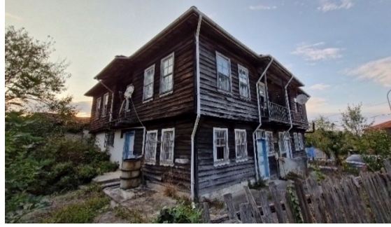
Şekil 18. Akçakese Köyü'nde özgünlüğünü büyük ölçüde korumuş ancak muhtes çatı katı aralığı ve yağmur iniş boruları gibi eklentiler alan geleneksel yapı, Hidayet Sokak, No:6A (28 Ağustos 2024'te yazar tarafından fotoğraflanmıştır).
