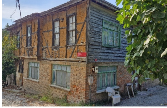
Şekil 17. Akçakese Köyü'nde zemin kat strüktürü betonarme döşeme ve harman tuğla ile değiştirilen, üst katlarında ise geleneksel ahşap karkas ve dal-örgü sistemi okunabilen geleneksel ev, Akçakese Caddesi No:51 (28 Ağustos 2024'te yazar tarafından fotoğraflanmıştır).
