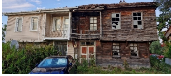
Şekil 24. Akçakese Köyü'nde 2 farklı aile tarafından kullanılan ikiz nizamlı 2 konut. Sağdaki özgünlüğünü büyük ölçüde korurken, soldaki yapı kapsamlı olarak yenilenmiş ve özgünlüğünü kaybetmiştir. Cuma Sokak, No:3-5 (28 Ağustos 2024'te yazar tarafından fotoğraflanmıştır).
