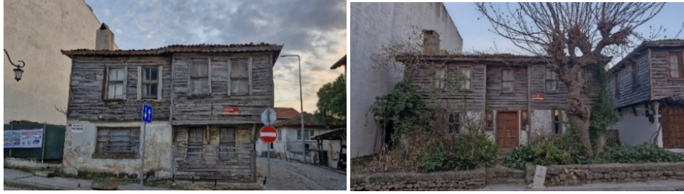
Şekil 40. Atatürk Caddesi No:2'de bulunan asimetric yapı ve No:19'da bulunan simetrik cepheli ikiz planlı yapıların zemin katlarındaki değişimler ve yapıların yanlarındaki betonarme yapılarla kurdukları ilişkiler (3 Nisan 2025'te yazar tarafından fotoğraflanmıştır).
