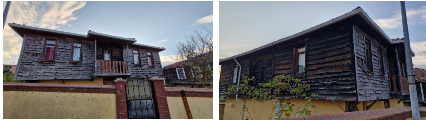
Şekil 19. Akçakese Köyü'nde özgünlüğünü büyük ölçüde korumuş ancak muhtes balkon korkuluğu ve yağmur iniş boruları gibi eklentiler alan ve zemin katı sıvanarak sarı renge boyanan geleneksel yapı, Hidayet Sokak, No:4 (28 Ağustos 2024'te yazar tarafından fotoğraflanmıştır).
