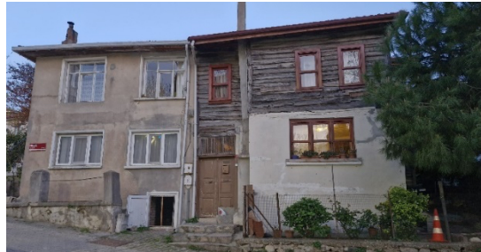
Şekil 13. Hacıkasım Mahallesi Müjde Sokağı’nda geleneksel Türk evine betonarme eklenti (3 Nisan 2025’te yazar tarafından fotoğraflanmıştır).
