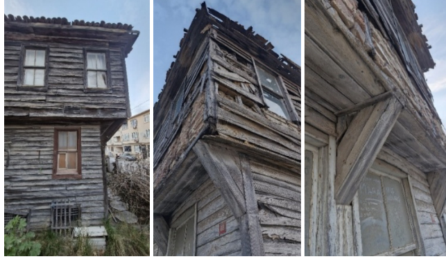
Şekil 9. Balibey Mahallesi’nde bulunan geleneksel evlerde çıkma ve payanda örnekleri (3 Nisan 2025’te yazar tarafından fotoğraflanmıştır).
