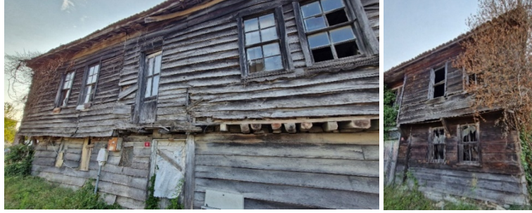
Şekil 28. Akçakese Köyü’nde terk edilen yapılarda bozunmanın hızlanması (28 Ağustos 2024’te yazar tarafından fotoğraflanmıştır).
