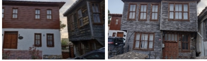
Şekil 47. Fener Caddesi No:11’de geleneksel yöntemlerle inşa edilen yeni konut yapısı ve yanındaki No:86’da yer alan tarihi yapı arasındaki ilişki (3 Nisan 2025’te yazar tarafından fotoğraflanmıştır).
