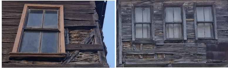
Şekil 10. Balibey Mahallesi’ndeki konutlardan ahşap kaplamanın kaybıyla açığa çıkan dal-örgü tekniği örnekleri (3 Nisan 2025’te yazar tarafından fotoğraflanmıştır).
