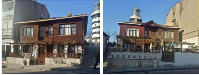
Şekil 53. Fener Caddesi'nde 21-23 numarada yer alan (envanter no:6) ve 25-27 numarada yer alan (envanter no:7) ikiz plan şemalı yapılar. Sağdaki yapının kuzey cephesinden betonarme ek aldığı görülmektedir (Aydın Cura, 2017, s. 74).
