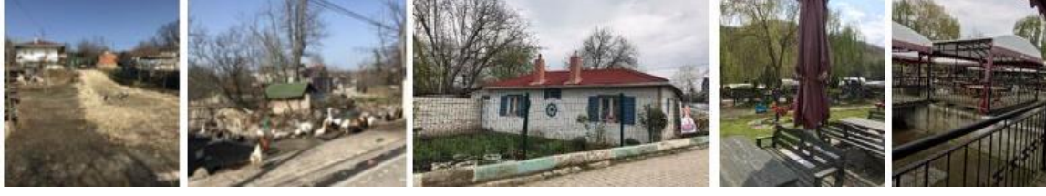
Şekil 15. Karamandere Mahallesi genel yapı dokusunun korunma düzeyi (Elif Beyza Sarsar Arşivi, 07.04.2023).
