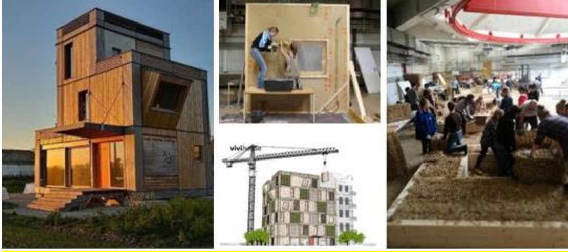
Şekil 12. Vivihouse, açık kaynak kullanımına imkân veren ilk prefabrik saman panel sistemi URL-20.
