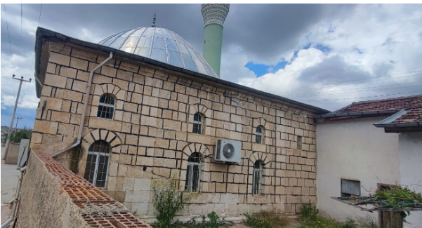
Şekil 15. Eski Şefaattli Camii'nin doğu cephesi, 2025.
