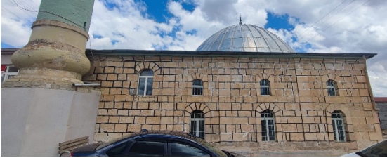
Şekil 13. Eski Şefaattli Camii'nin batı cephesi, 2025.
