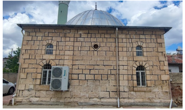
Şekil 16. Eski Şefaattli Camii'nin güney cephesi, 2025.
