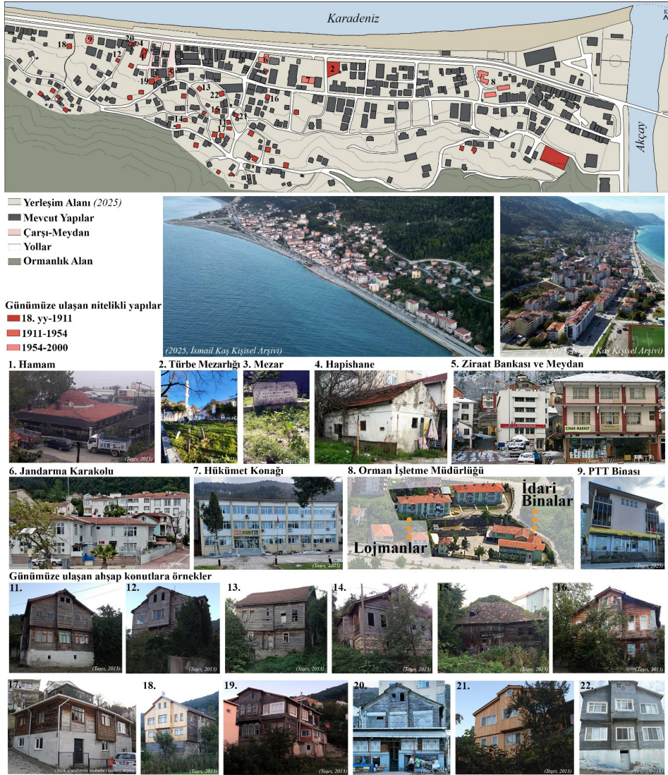
Şekil 5: Günümüzde Çatalzeytin ilçesi yerleşim planı ile günümüze ulaşan nitelikli yapılar
