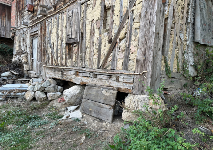
Fot. 20: Dikmelerin altında bulunan taş
