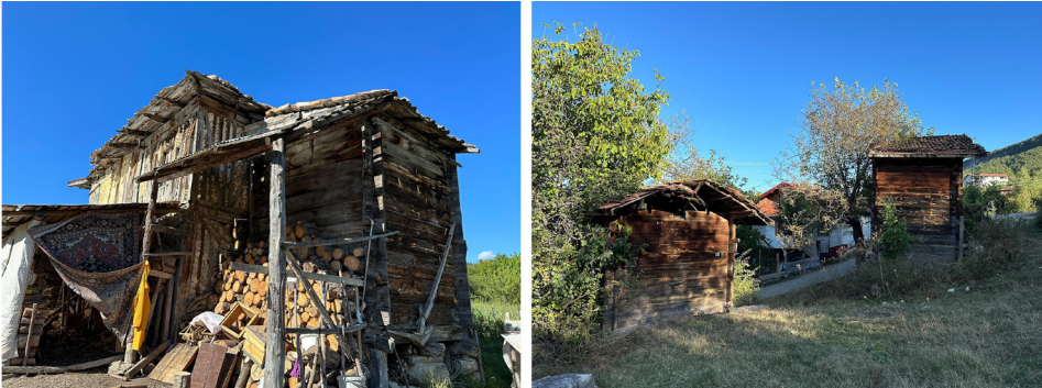
Fot. 2: Yapıdan bağımsız ve yapıya bitişik ambar örnekleri; a) Avlağıkaya köyü Karşı mahalle; b) Anbarözü köyü Merkez mahalle
