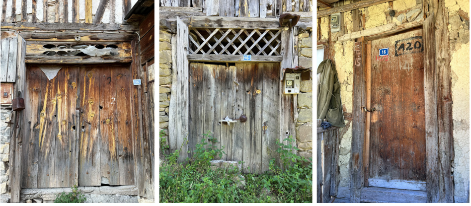
Fot. 15: Ahşap kapı örnekleri
