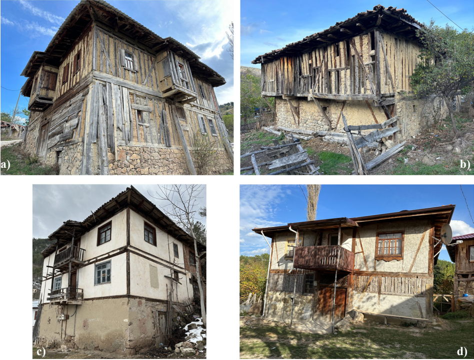
Fot. 16: Açık ve kapalı çıkma türleri. a) Çardağın orta bölümünde kapalı çıkma b) Cephe boyunca çıkma c) Balkon şeklinde açık çıkma d) Dikmelerle desteklenen açık çıkma
