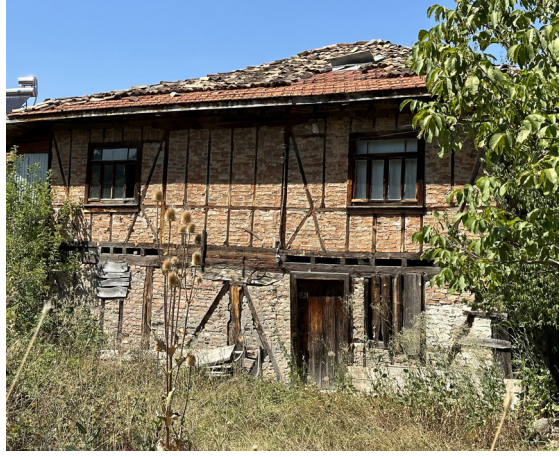
Fot. 21: Ahşap karkas sistemde dolgu malzemesi olarak kullanılan ateş tuğlası
