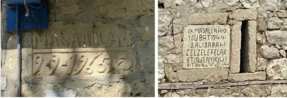
Fot. 25: Taş duvar üzerine işlenen yapım tarihi
