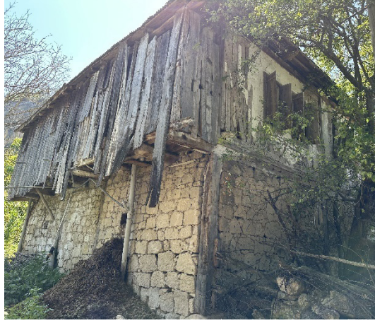
Fot. 17: Daraba tahtalarıyla kapatılan ıslak hacim çıkması
