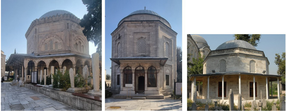
Görsel 5: Soldan sağa: Kanuni Sultan Süleyman Türbesi, Hürrem Sultan Türbesi, Piyale Paşa Türbesi.
