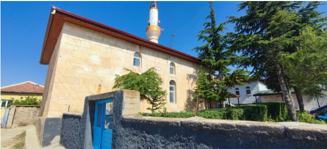
Şekil 21. Kazlıuşağı Köyü Çapanoğlu Camii'nin doğu cephesi, 2025.
