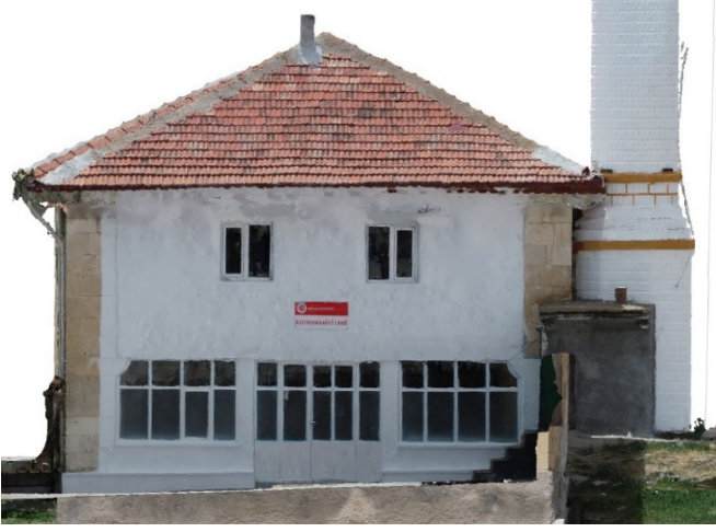
Şekil 6. Kazlıuşağı Köyü Çapanoğlu Camii'nin fotogrametrik modelini kuzey cephe görünümü.
