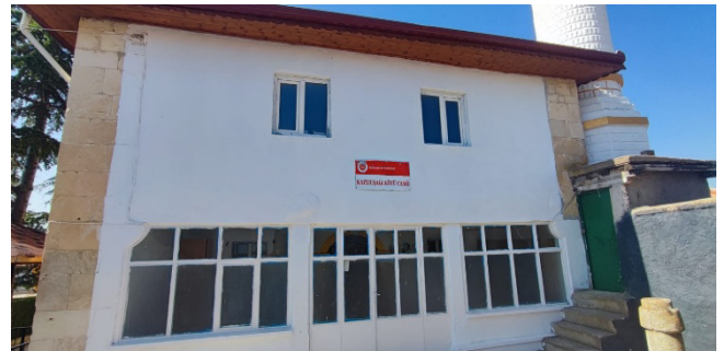
Şekil 18. Kazlıuşağı Köyü Çapanoğlu Camii'nin kuzey cephesi, 2025.
