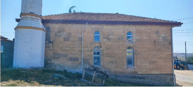
Şekil 19. Kazlıuşağı Köyü Çapanoğlu Camii'nin batı cephesi, 2025.
