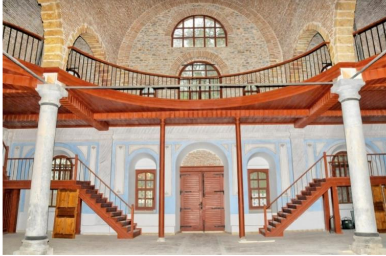
Şekil 5. Naos giriş bölümü ve giriş üzerinde yer alan ahşap galeri katı
