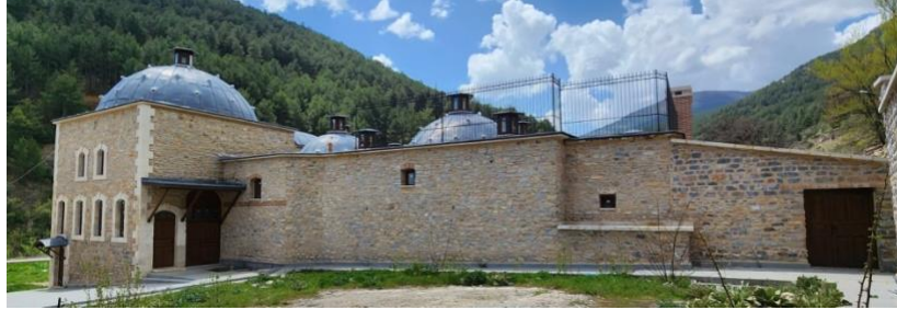
Şekil 27. Hamamın doğu cephesi
