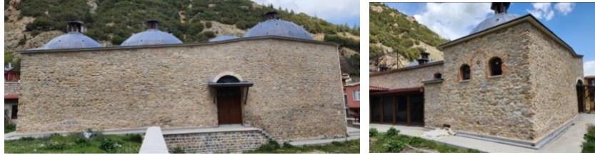
Şekil 28. a) Güney cephesi b) batı cephesinin görünümü
