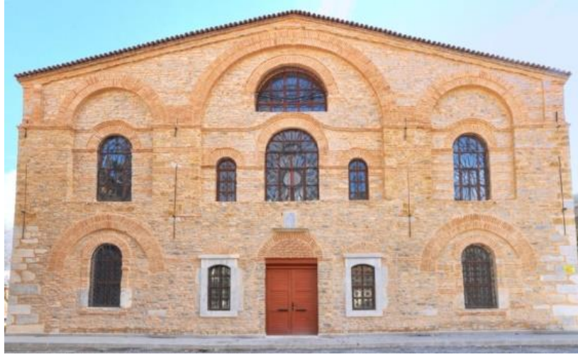
Şekil 7. Kilise kuzeybatı cephesi görünüşü
