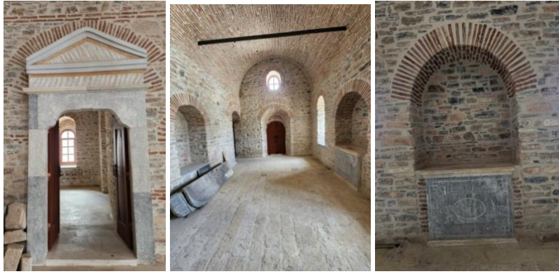
Şekil 4. a) Ek mekânların yan neflere açılan kapısı, b) mekânın içeriden görünümü, c) duvar içerisine açılan niş
