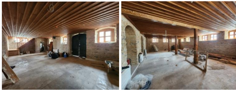
Şekil 17. a) Bodrum kat holü b) Hole açılan mekanlar
