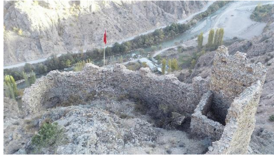
d) Bahçeli Kalesi İç Kısmında Sıvasız Duvarlar (Yazarın Kişisel Arşivi)
