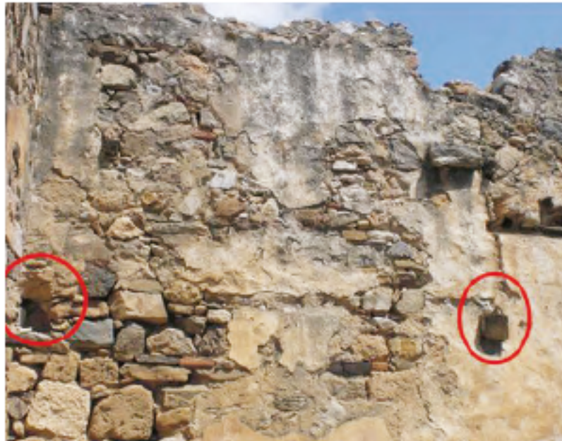
Res. 16 - Üst kata çıkışı sağlayan ahşap merdivenin yerleştirildiği kuzeybatı köşe.
