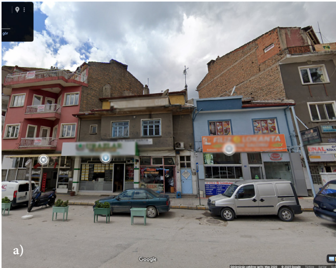
Şekil 29: Yığma yapılarda yumuşak kat olumsuzluk parametresi örnekleri. a) Örnek 1, b) Örnek 2 Figure 29: Examples of soft storey negativity parameters in masonry structures. a) Example 1, b) Example 2
