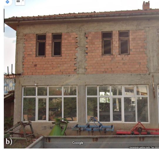
Şekil 24: Kuşatılmış yığma bina örnekleri. a) kuşatılmış yığma bina, b) kuşatılmış karma bina Figure 24: Examples of confined masonry building. a) confined masonry building, b) confined combined building
