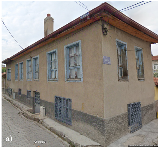
Şekil 25: Yığma yapı görsel inceleme örnekleri a) Duvar miktarı ve düşey boşluk düzensizliği, b) Farklı duvar malzemeleri ile yapılmış duvarlar Figure 25: Examples of visual inspection of masonry structures a) Amount of walls and vertical space irregularity, b) Walls made with different wall materials
