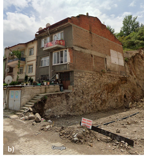
Şekil 26: Yığma yapılarda olumsuzluk parametrelerine örnekler a) Düzensiz bina, b) Cephelere göre değişen kat sayısı
