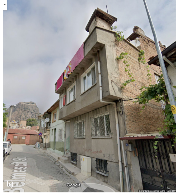
Şekil 28: Yığma yapılarda farklı olumsuzluk örnekleri a) Kat ilavesi, b) Ağır çıkma Figure 28: Different examples of negativities in masonry structures a) Addition of floors, b) Heavy overhang
