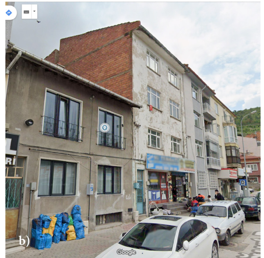
Şekil 29: Yığma yapılarda yumuşak kat olumsuzluk parametresi örnekleri. a) Örnek 1, b) Örnek 2 Figure 29: Examples of soft storey negativity parameters in masonry structures. a) Example 1, b) Example 2
