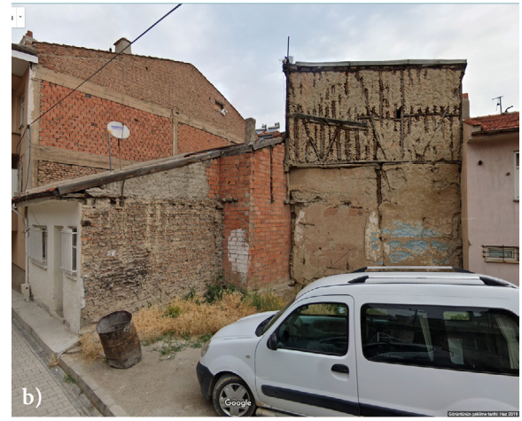
Şekil 25: Yığma yapı görsel inceleme örnekleri a) Duvar miktarı ve düşey boşluk düzensizliği, b) Farklı duvar malzemeleri ile yapılmış duvarlar Figure 25: Examples of visual inspection of masonry structures a) Amount of walls and vertical space irregularity, b) Walls made with different wall materials
