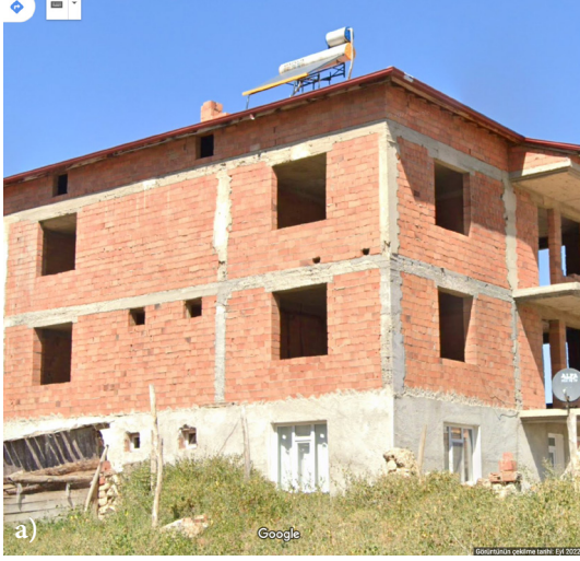
Şekil 24: Kuşatılmış yığma bina örnekleri. a) kuşatılmış yığma bina, b) kuşatılmış karma bina Figure 24: Examples of confined masonry building. a) confined masonry building, b) confined combined building
