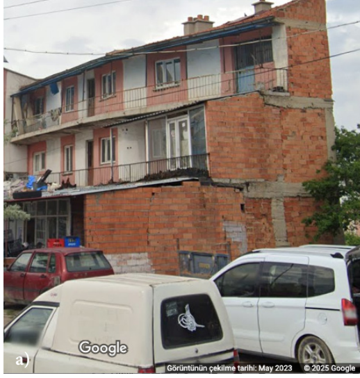
Şekil 26: Yığma yapılarda olumsuzluk parametrelerine örnekler a) Düzensiz bina, b) Cephelere göre değişen kat sayısı
